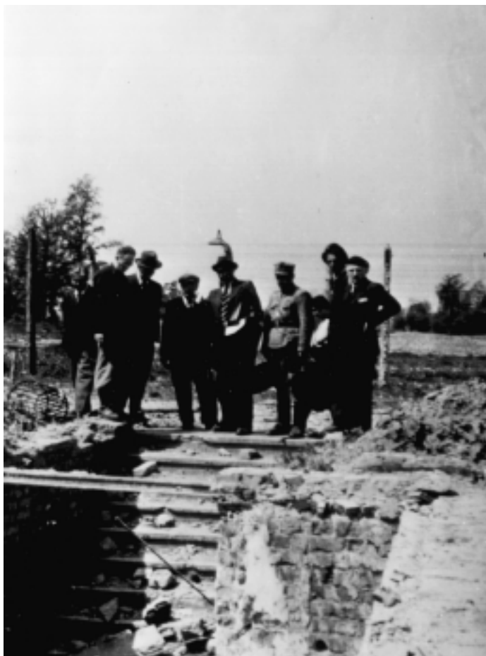
59 Medlemmer af den polske undersøgelseskommission foran nedgangen til afklædningskælderen i Krematorium II, maj 1945
